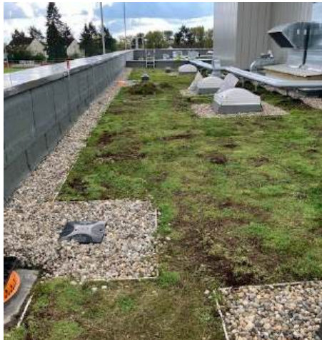
Baustelle Bad Homburg
